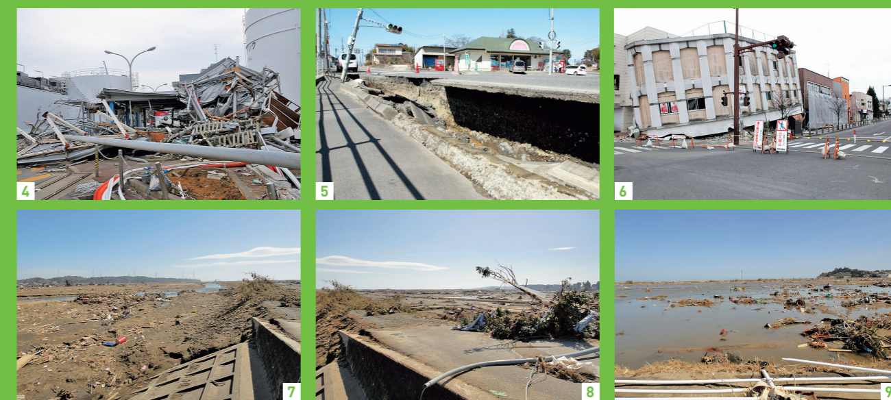
1 浪江町戸を襲った津波で町は壊滅状態に 2 いわき市久之浜地区も津波被害を受け、火災も発生した 3 相馬市相馬港周辺。ここでも火災の様子が見取れる 4 東京電力福島第一原発。構内はがれきの山となり炉心が溶融する事態に 5 須賀川市吉美根地区。道路は陥没して通行不能になった 6 須賀川市八幡町。建物物が座屈して危険な状態に 7 南相馬市や相馬市も津波に見舞われ、なぎ倒された木々やがれきが散乱した 8 南相馬市～相馬市付近。巨大な波は堤防を乗り越え町を飲み込んだ ※写真提供: 福島県
